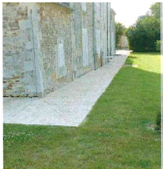
Exemple de réalisation d'un revers pavé pour recueillir les eaux de gouttières
