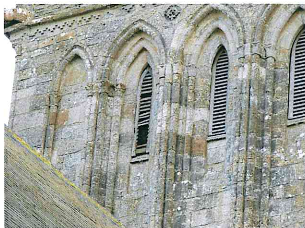
Restauration des abat-sons
