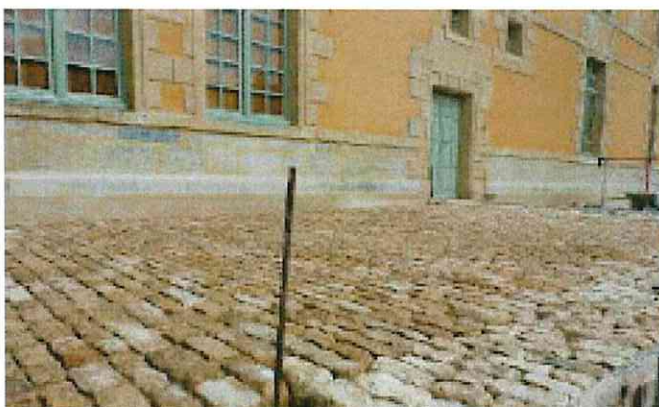
Exemple de réalisation d'un revers pavé pour recueillir les eaux de gouttières
